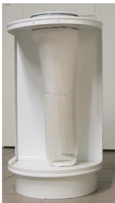
Fot 10. Nawiewnik z założonym filtrem i opaską.
