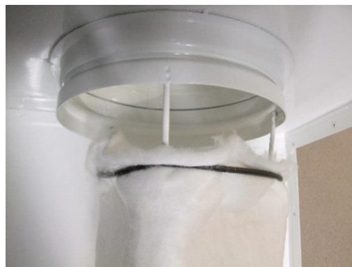
Fot 5. Widok filtra zsuniętego z króćca.
