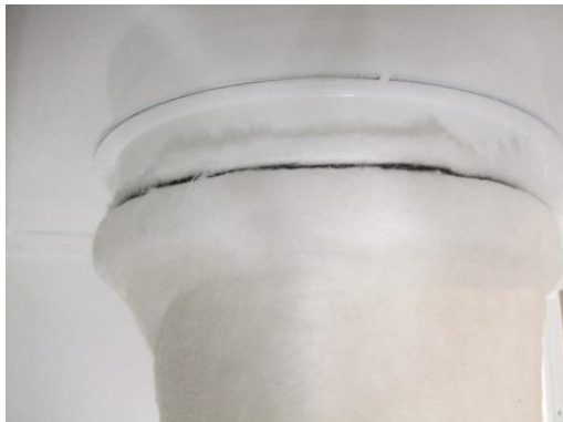
Fot 3. Widok mocowania filtra na króćcu wewnętrznym za pomocą elastycznej opaski.
