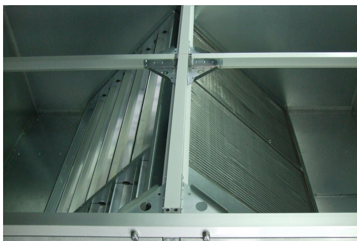
Zdj. nr 16 Sekcja wymiennika krzyżowego, przepustnica dwusekcyjna.
